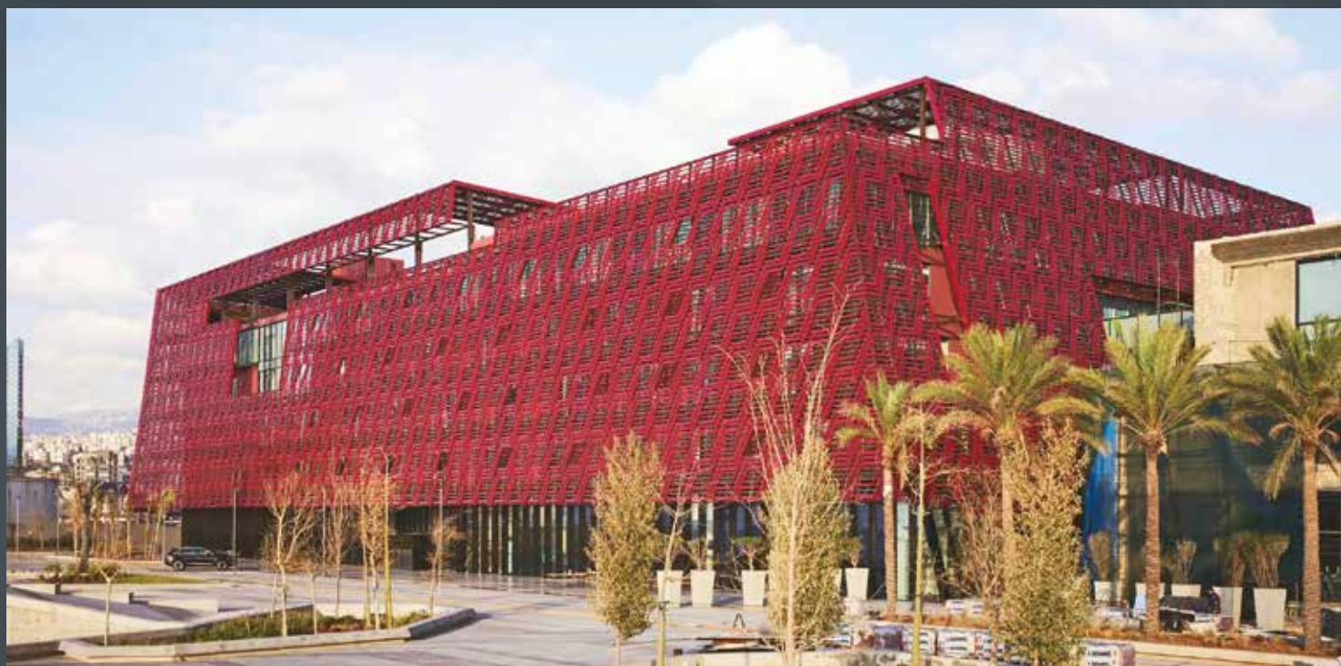
Rivestimento esterno a campione Aishti Foundation (Beirut, Libano)
